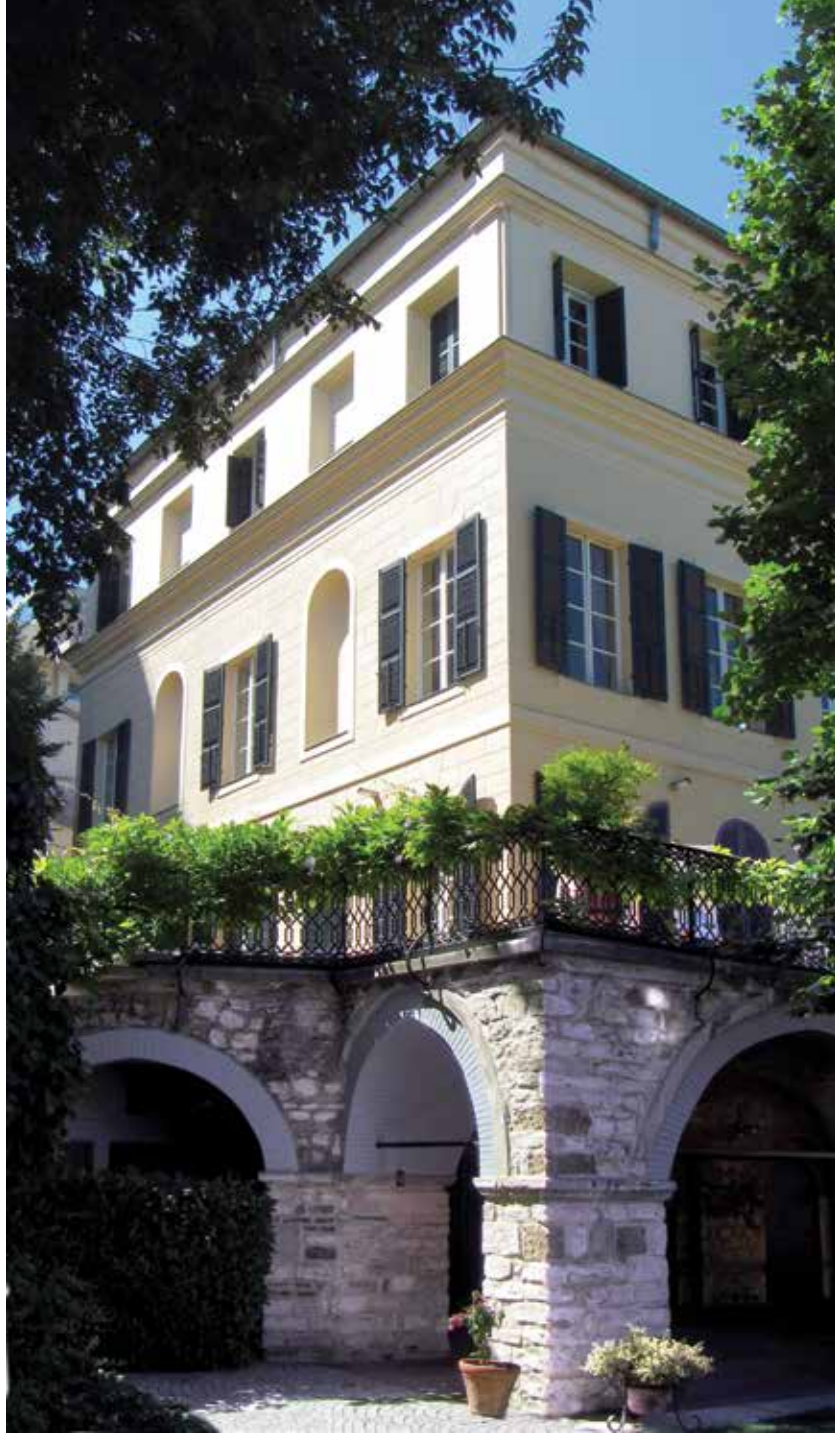
Bahçeden görülen Başkonsolosluk binası
